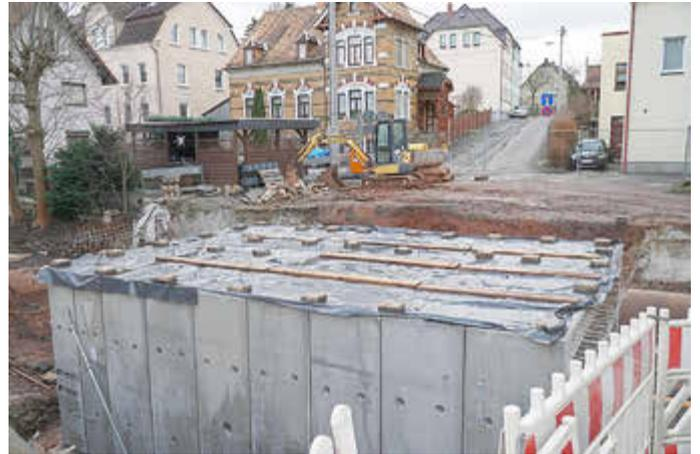
Am 16. und 17. Dezember erfolgte die Lieferung und der Einbau der Stahlbetonfertigteile in das Bachbett der Pleiße. Die Baustelle wurde gesichert und die Arbeiten vorübergehend eingestellt. Die Wiederaufnahme der Arbeiten erfolgt frühestens im Januar, in Abhängigkeit von der Witterung. Für die Anwohner ist eine Behelfsumfahrung errichtet.
