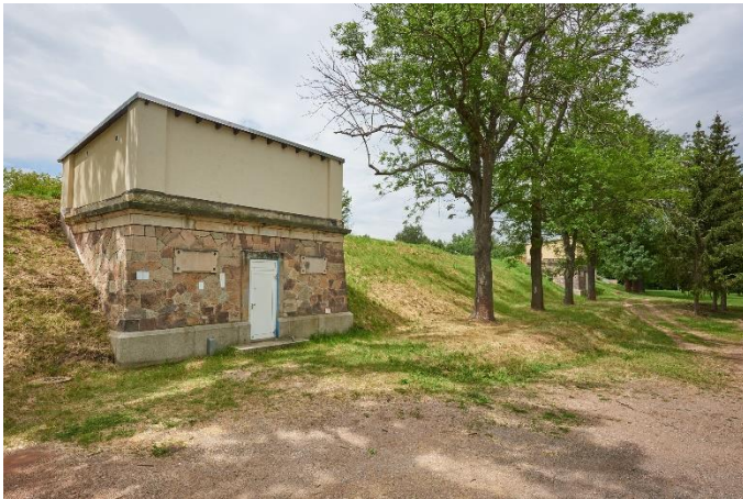
Bild: 52 Trinkwasserbehälter wie dieser sind Bestandteil unserer Trinkwasserversorgung. Quelle: Wasserwerke Zwickau GmbH - Foto-Atelier Lorenz
