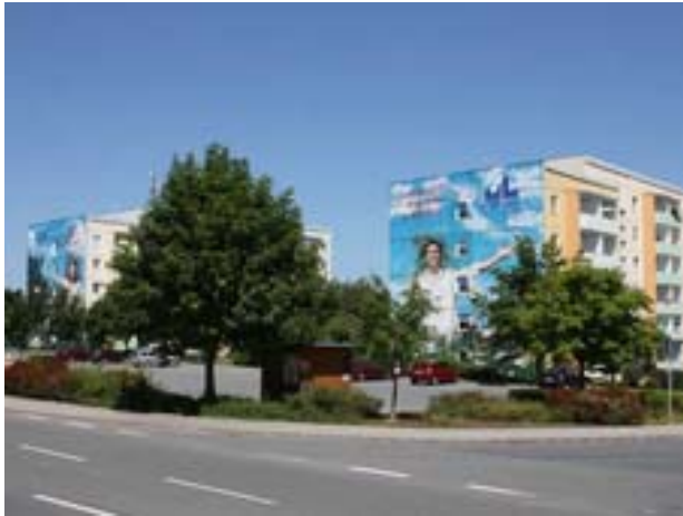
Freianlagen an Seniorenwohnungen in der Sorge
