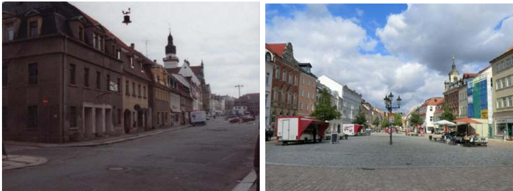
Marktplatz Werdau, vor und nach der Sanierung Fotos www.werdau.de
